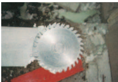
Fig. 18 – Intervento di risanamento eseguito su parete a blocchi in calcestruzzo alveolare, con intercapedine, per mezzo di una sega a doppia lama su un dorso lungo 5 metri [7.14]
